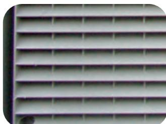
*Durch in die Füllstäbe gestanzte Löcher sind die Gitteroste praktisch „unsichtbar“ auf die Unterkonstruktion zu schrauben.*
